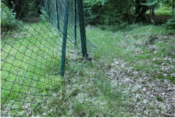
Abb. 12 Landessammelstelle, Loch im Maschendrahtzaun, Nordecke 05.08.2024 #1452
