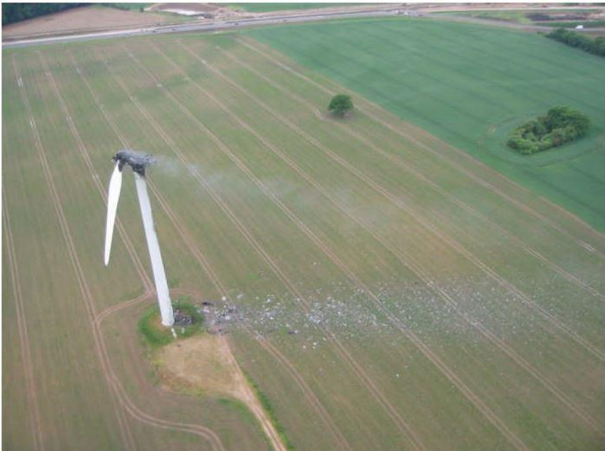
Abb. 19 Illustration aus der DFV-Fachempfehlung, Foto ©Holger Bauer, nach Brand einer NEG Micon NM72/2000 auf 64 m-Turm, Baujahr 2000 im Windpark Wulfshagen in Gettdorf bei Kiel im Jahre 2004
